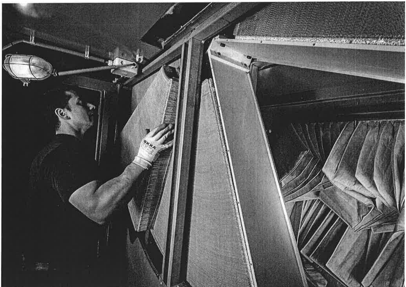
Renovatie van een warmtewiel.
