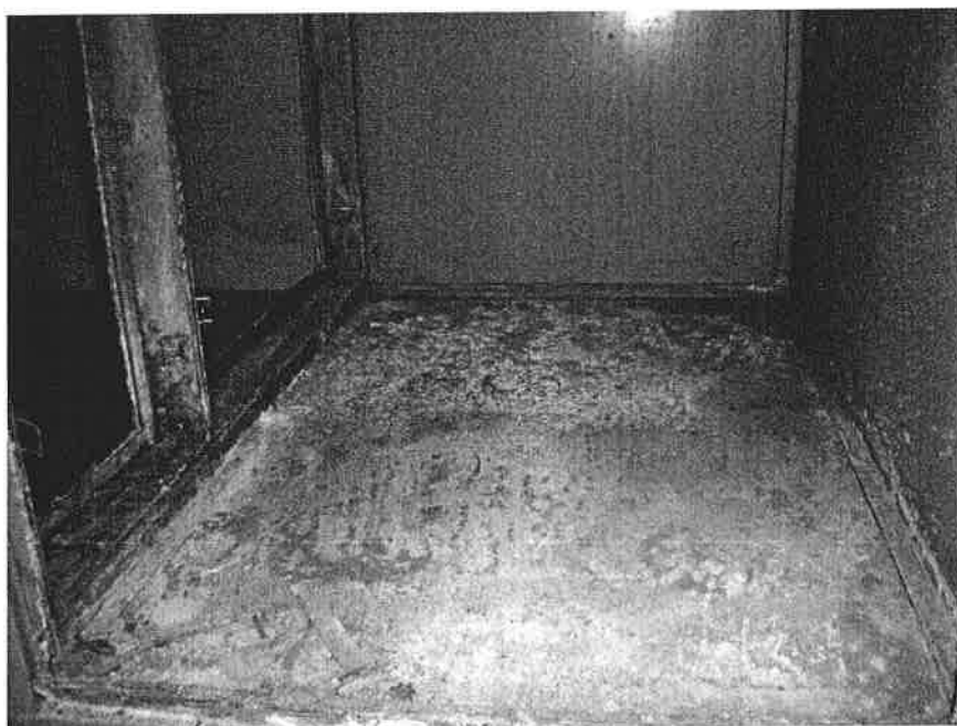
Luchtbehandelingskast voor renovatie.
